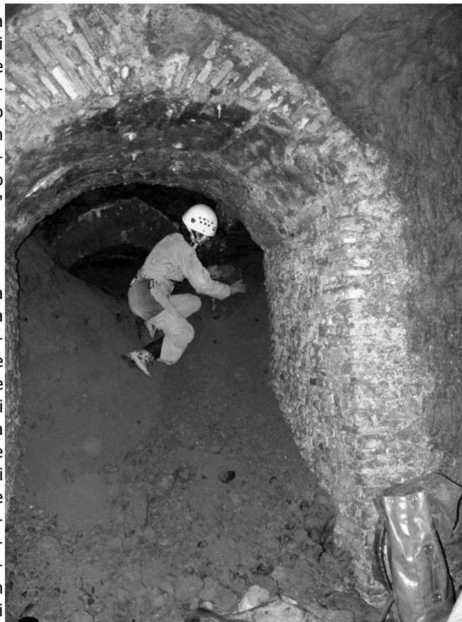
Una delle frane che ostruiscono le cantine del monastero (foto M. Vitelli, ASSO).
