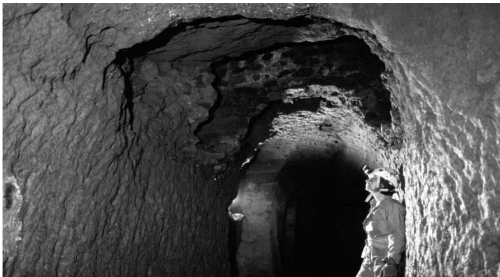
Cunicolo idraulico intercettato dalle cantine del Monastero ed appartenente con molta probabilità all'antica villa romana sulle cui rovine venne costruita la chiesa di S. Maria di Grottaferrata (foto C. Germani, CRSE).
